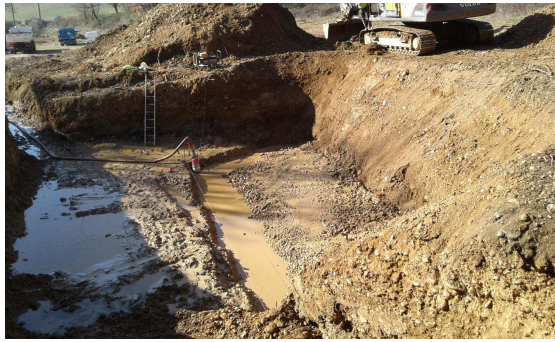
FIGURE 5 – Mise en place du système drainant de S3 : décaissement de 3.5m sous le terrain naturel. Le substratum n'est pas atteint. Photo DVLA
