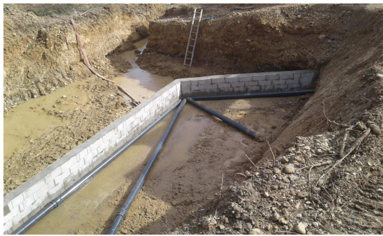
FIGURE 6 – Mise en place du système drainant de S3 : entonnement et drains PVC crépinés. Photo DVLA
