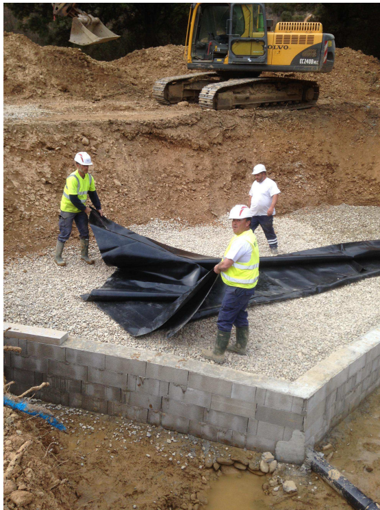
FIGURE 7 – Mise en place du système drainant de S3 : massif drainant, recouvrement du massif par géomembrane couverte d'un géotextile anti-contaminant. Source S3. Photo Prima Provence
